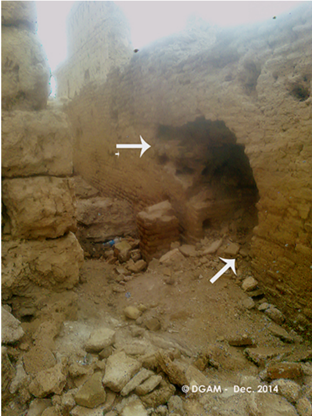
Deterioration of masonry at Qal'at Rahba/Rahba Castle (DGAM).
